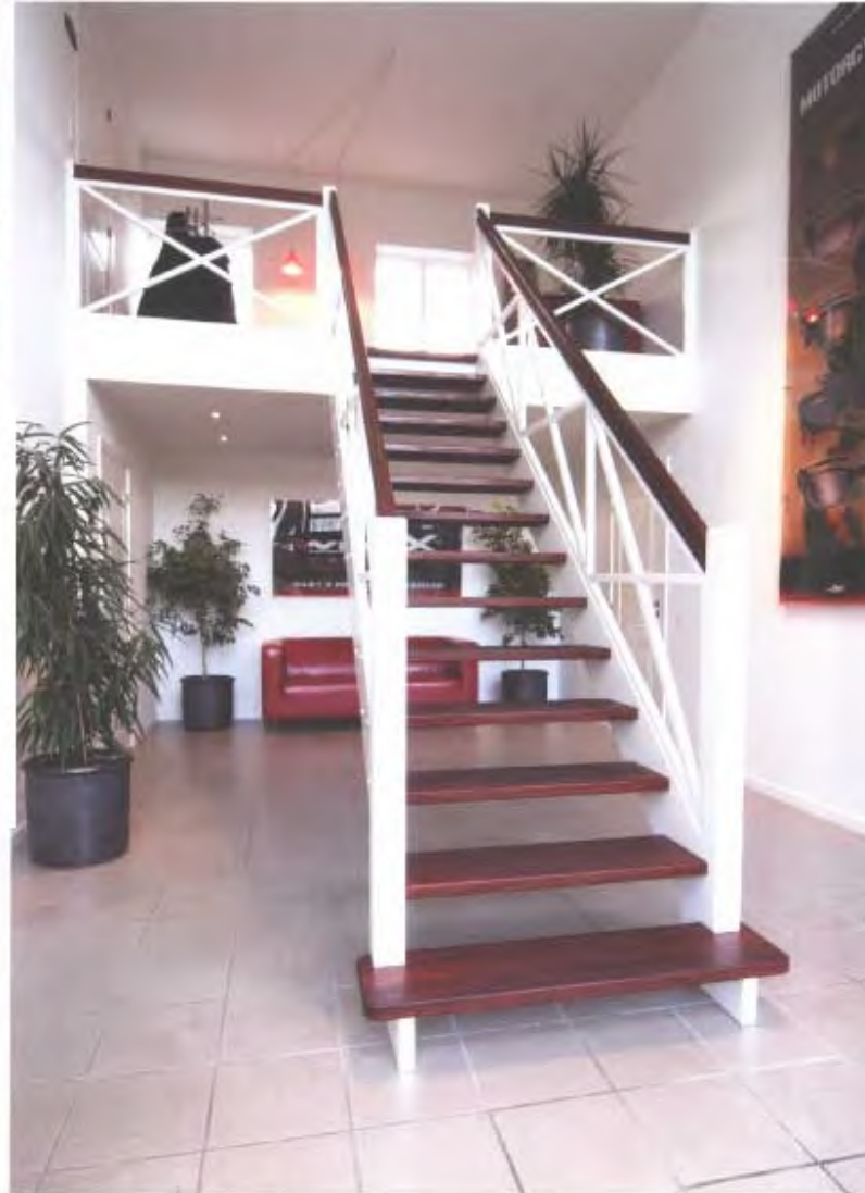
Hvítlakkaður beinn stigi með þrep og handlista úr Jatoba. Fyrsta þrepið er breiðara, nær útfyrir stólpana.
