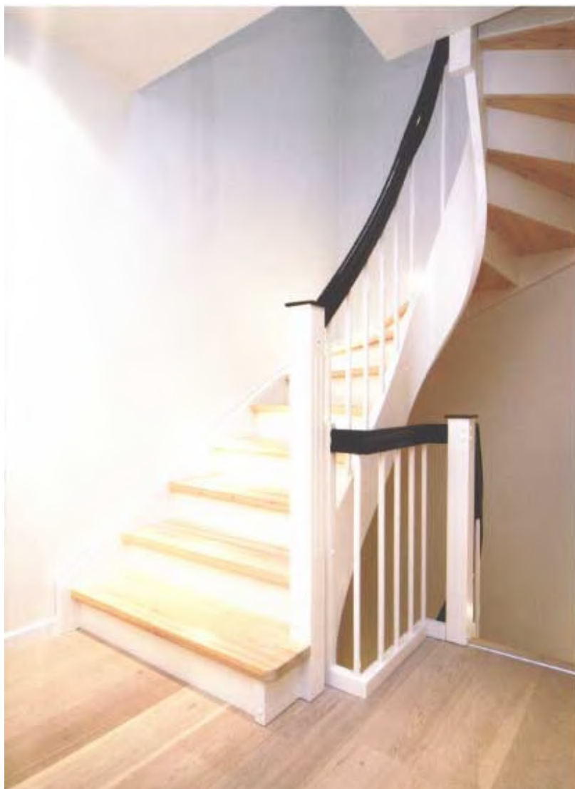
Hvítlakkaður 1/2 snúinn stigi með Furuprepum og svart lökkuðum handlista. Boginn handlisti og vangí í snúningi.
