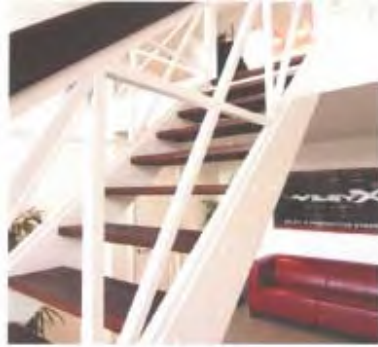
Handriðafyllingin eru hvítlakkaðir krossar úr Beyki.
